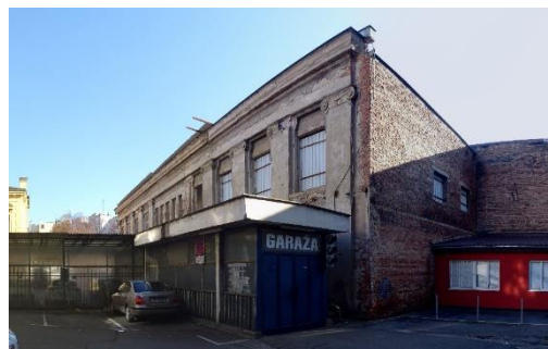
slika 11. sjeverno pročelje Zgrade skladišta
