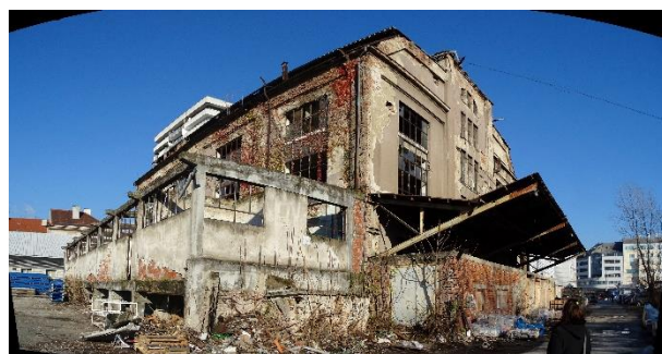
slika 9. Zgrada tvornice pjenice
